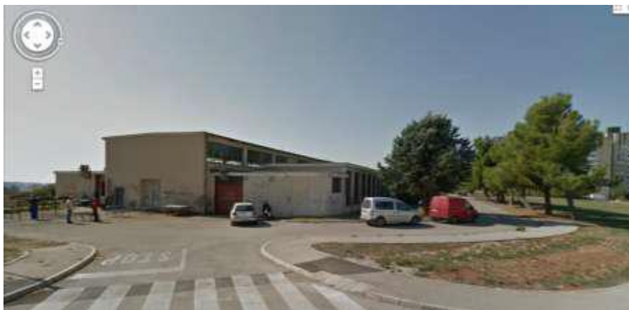
Slika 34. Istočno pročelje Industrijsko - obrtničke škole Pula prije rekonstrukcije
