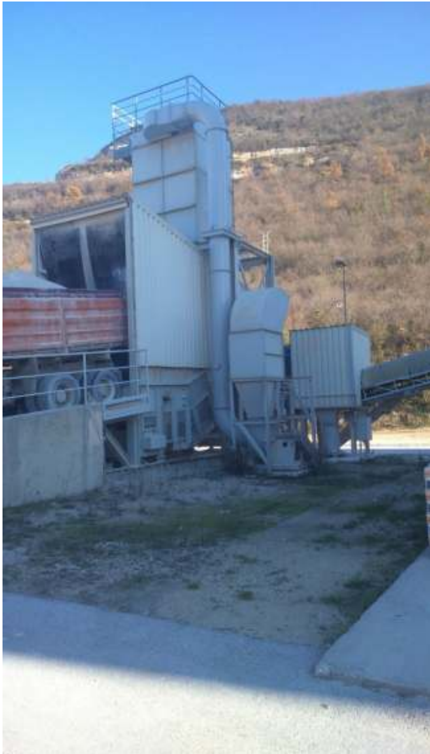
Slika 10.: Kamion dovozi frakcije u prihvatni uređaj koji pokretnom trakom transportira frakcije u silose
