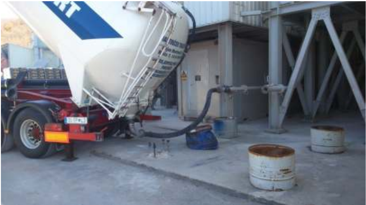
Slika 12.: Dopremanje veziva auto cisternom
