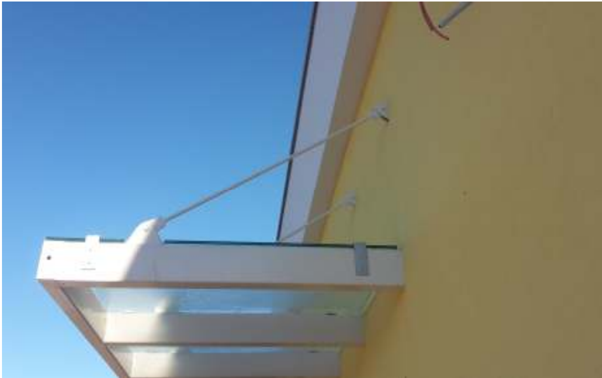
Slika 28: Bočna strana montirane nadstrešnice
