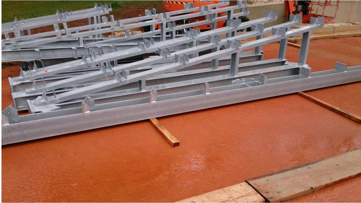
Slika 17. Prikaz izrađenog i pocinčanog segmenta
