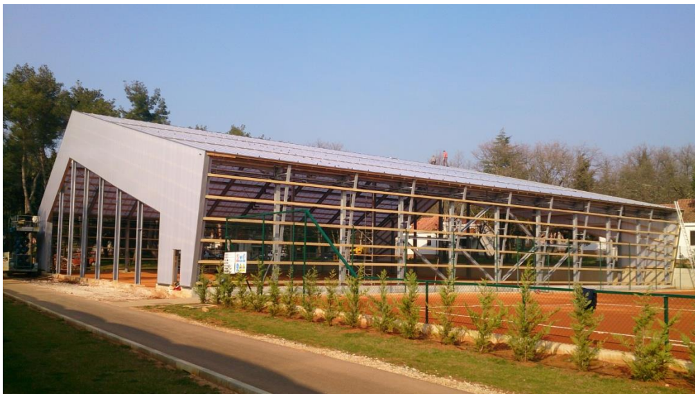
Slika 14. Čelična konstrukcija u Umagu [7]
