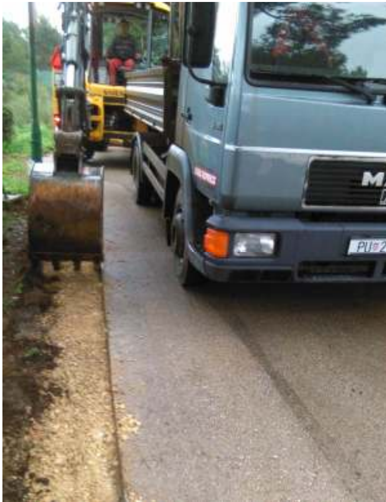
Slika 6.2.2.3. Primjer strojnog uklanjanja asfaltnog sloja [3]
