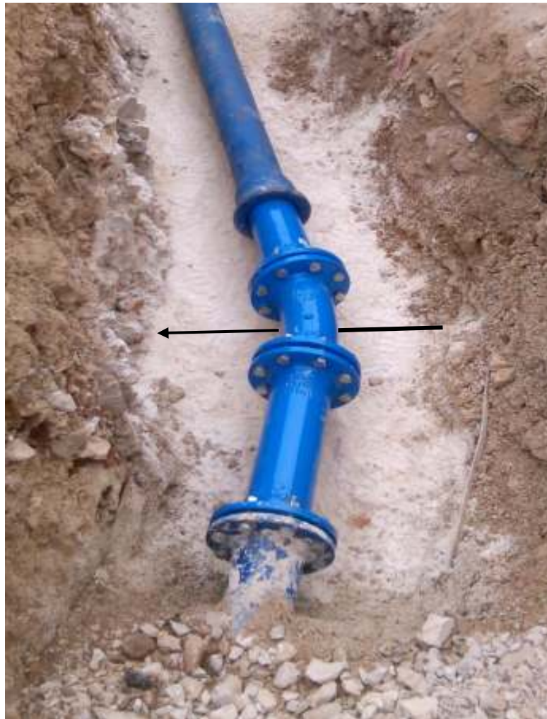
Slika 6.5.1. Nastavak čvora 4 prema podzemnom hidrantu [3]
