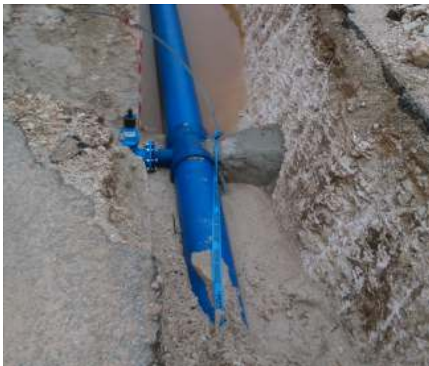
Slika 6.5.3. Betonski uporište fazona od nodularnog lijeva [3]
