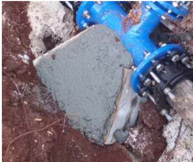
Slika 6.5.4. Primjer zaštite vijaka kod izrade betonskog uporišta [3]
