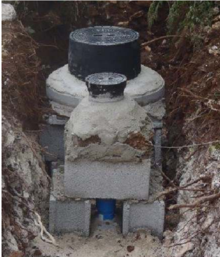
Slika 6.5.6. Zidanje podzemnog hidranta sa pripadajućim zasunom [3]
