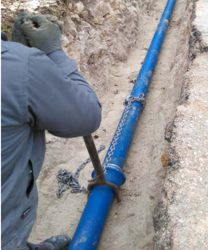
Slika 6.4.2. Naprava za spajanje cijevi sa naglavkom [3]
