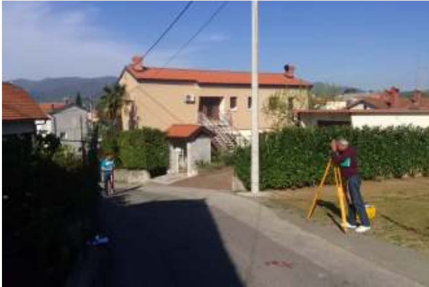
Slika 4.1.1.2. Primjer iskolčenja trase polarnom metodom [2]
