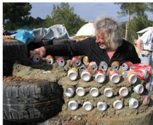
Slika 39. Zidanje zidova korištenjem odbačenih aluminijskih limenki
