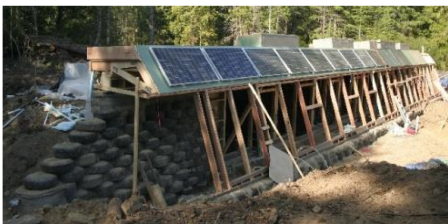
Slika 42. Smještaj i izgled fotonaponskih ćelija za proizvodnju električne energije na Earthshipu
