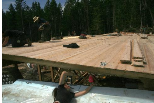
Slika 40. Postavljanje drvene oplata na krov Earthshipa
