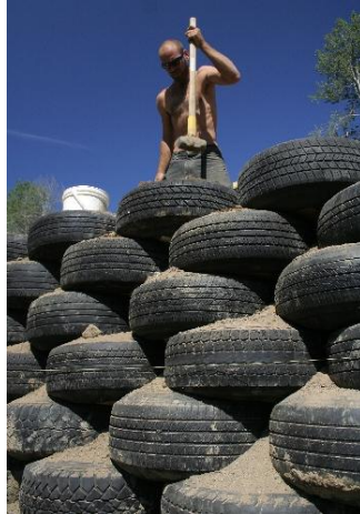
Slika 38. Izgled dijela nosivog zida načinjenog od odbačenih automobilskih guma punjenih sabijenom zemljom
