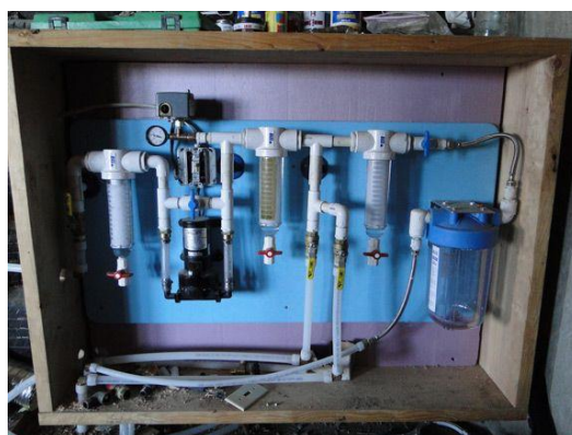
Slika 44. Sustav tj. modul za filtraciju i organizaciju vode
