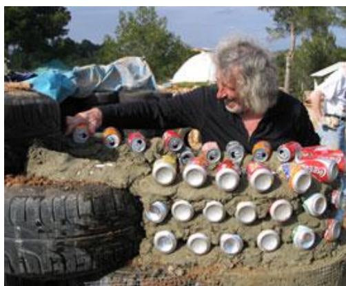
Slika 39. Zidanje zidova korištenjem odbačenih aluminijskih limenki
