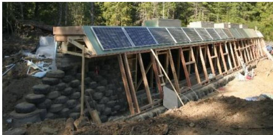
Slika 42. Smještaj i izgled fotonaponskih celija za proizvodnju električne energije na Earthshipu
