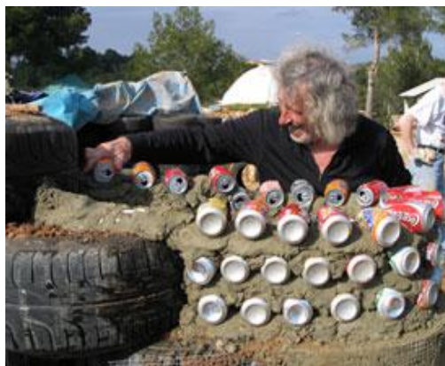
Slika 39. Zidanje zidova korištenjem odbačenih aluminijskih limenki
