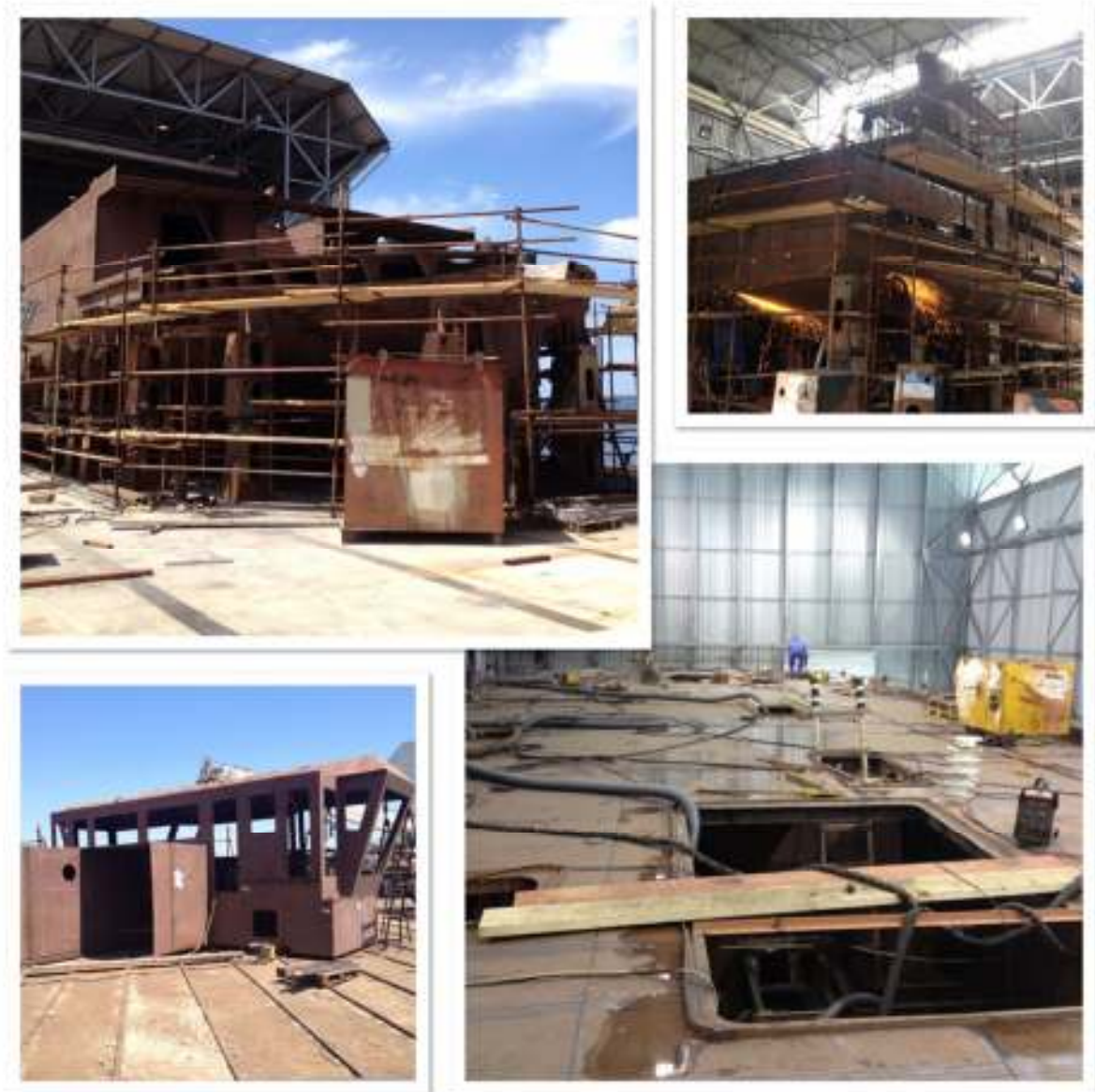
Slika 19. Gradnja glavne i gornje palube, te gradnja kormilarnice.
