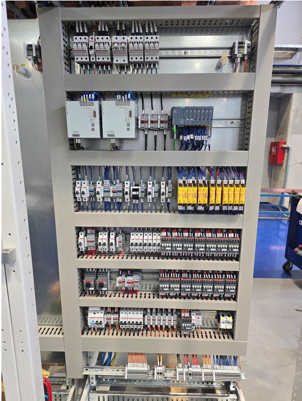
Slika 20. Dovršeno ožičenje temeljne ploče.
