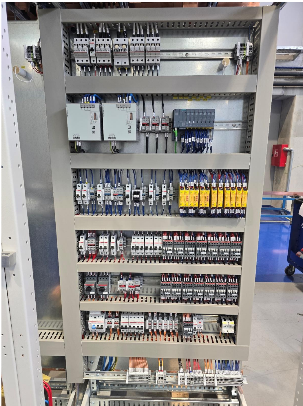
Slika 20. Dovršeno ožičenje temeljne ploče.
