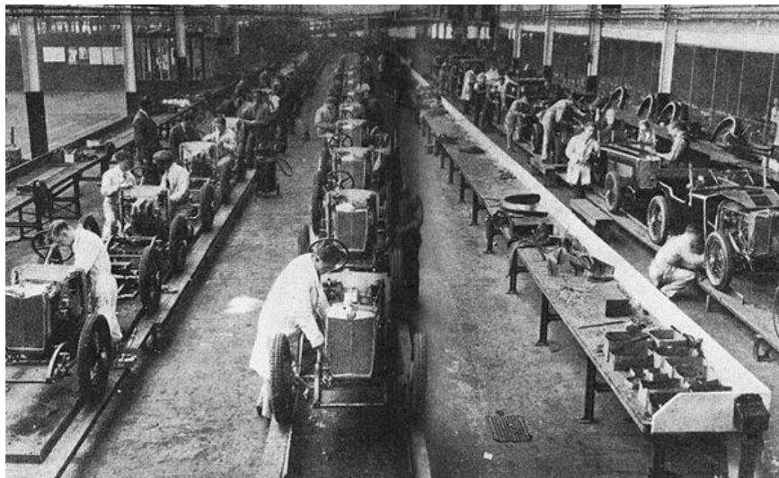
Slika 2: Prikaz pokretne linije u tvornici Ford
