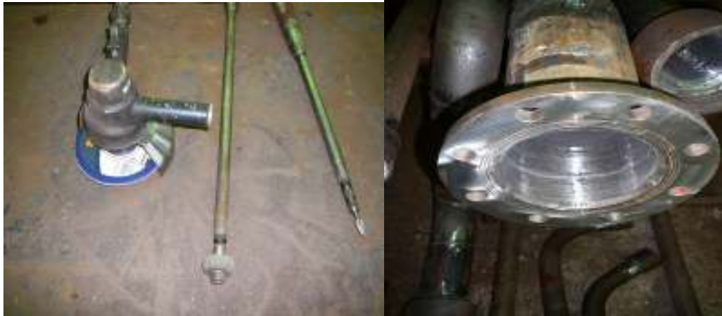
Slika 21. Alati za brušenje i cijevi nakon brušenja
