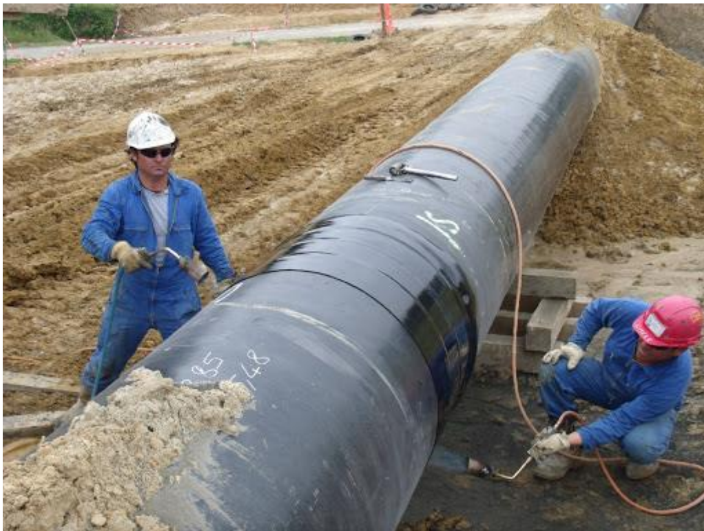
Slika 16. Primjer bitumenizacije cjevovoda
