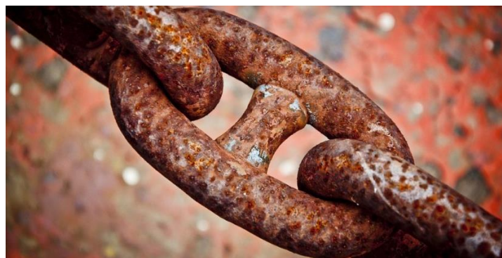
Slika 1. Primjer hrđanja željeza
