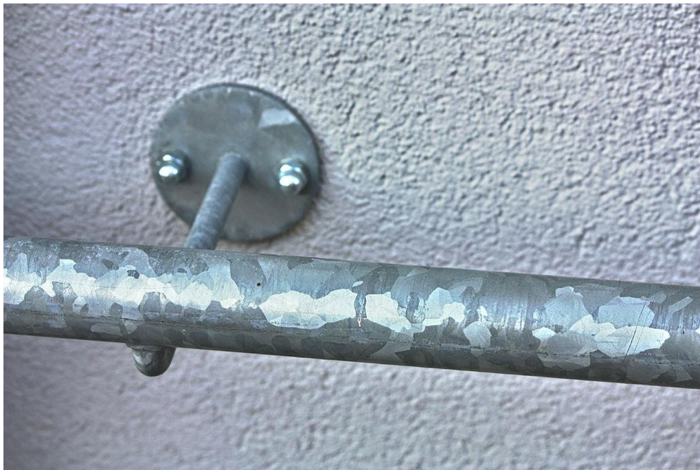
Slika 14. Prikaz karakterističnog uzorka koji posjeduje galvanizirani čelik
