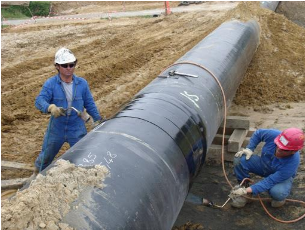
Slika 16. Primjer bitumenizacije cjevovoda
