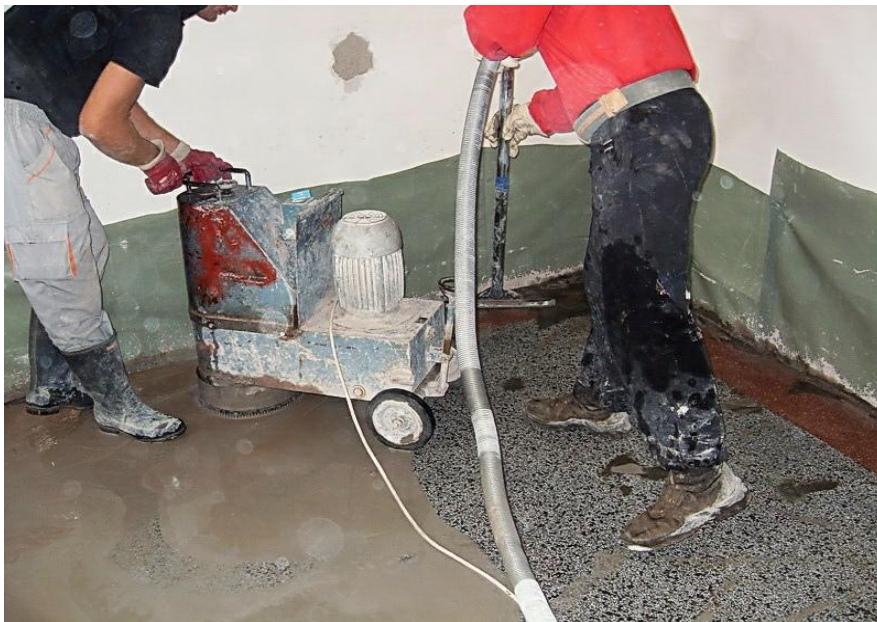
Slika 34. Brušenje i poliranje kulir poda
