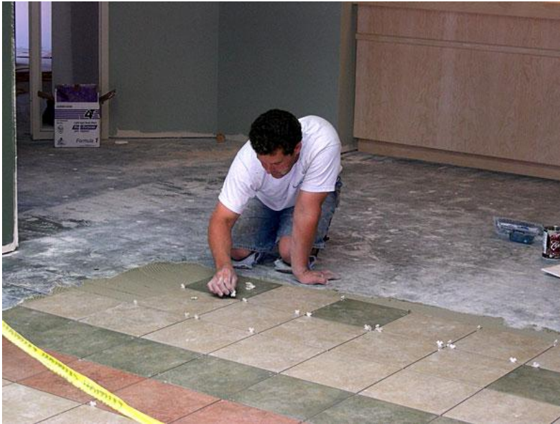
Slika 31. Postavljanje pločica
