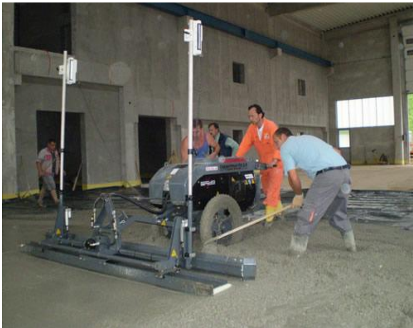
Slika 32. Poravnavanje laserskom vibro letvom
