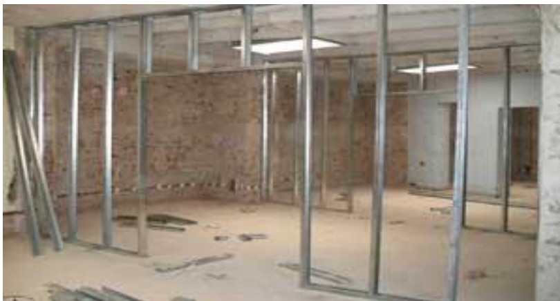
Slika 38. Konstrukcije pregradnih zidova za postavljanje knaufa
