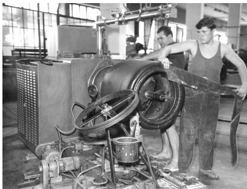
Slika 6 – Konfekcioniranje automobilskih guma u tvornici Borovo, 1960-tih
