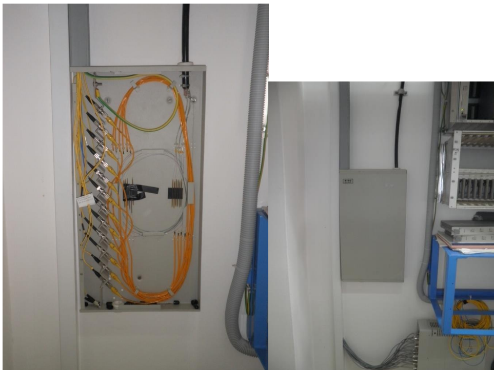
Slika 18: Zidni razdjelnik RIKO bez/sa poklopcem
