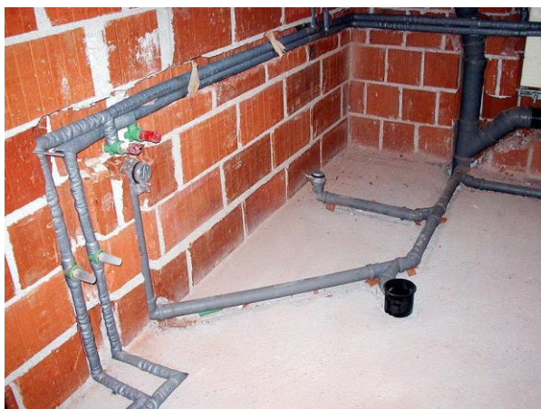
Slika 14 – Montaža vodovodne instalacije. Izvor 35
