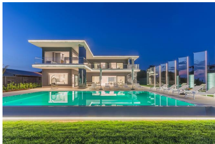
Slika 5 –Primjer moderne kuće za odmor. Izvor: 23
