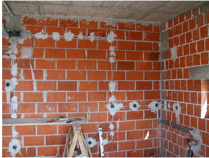
Slika 15 – Montaža strujne instalacije. Izvor 36
