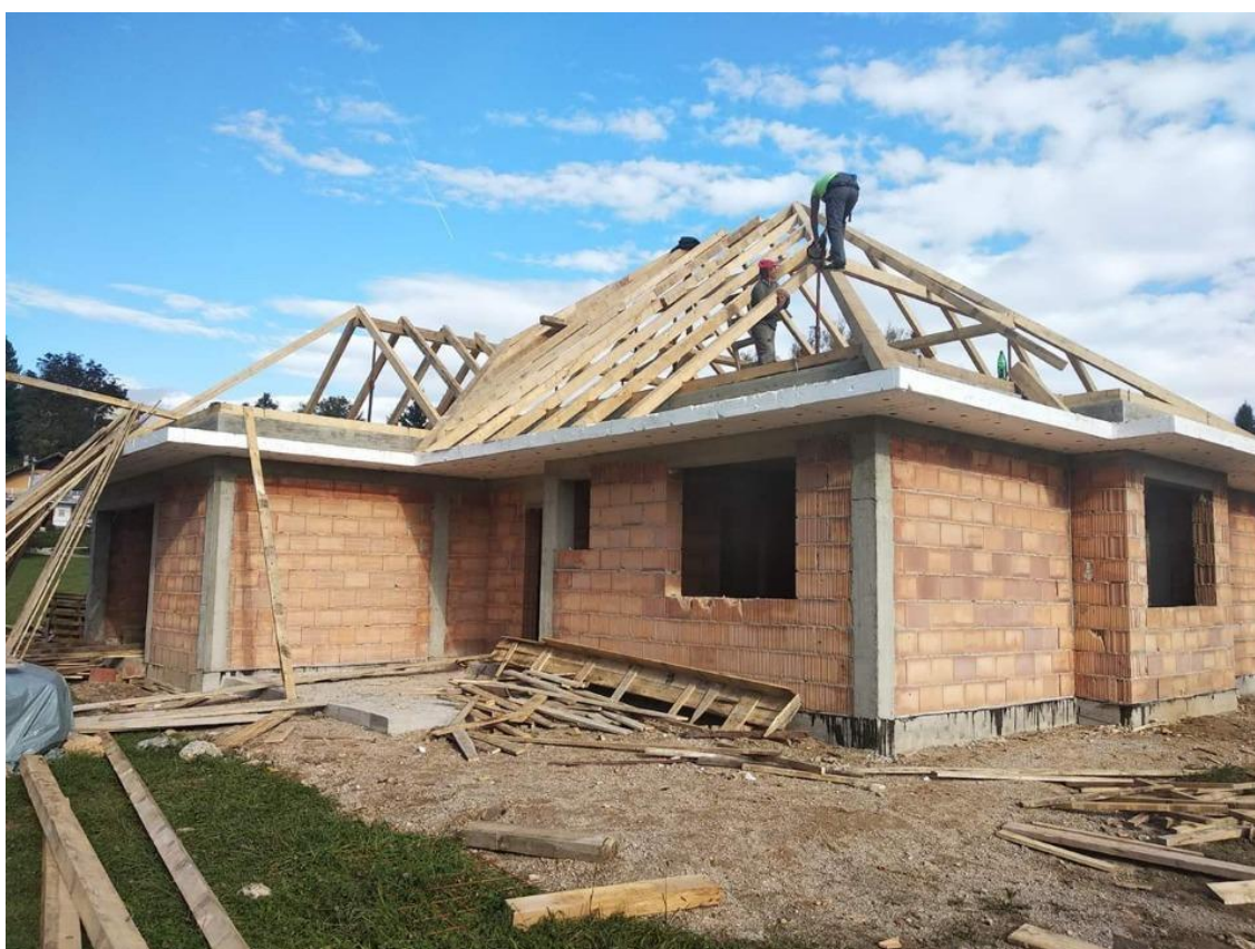
Slika 12 –Izrada krovništva. Izvor 33
