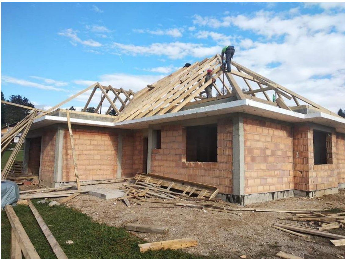
Slika 12 –Izrada krovništva. Izvor 33
