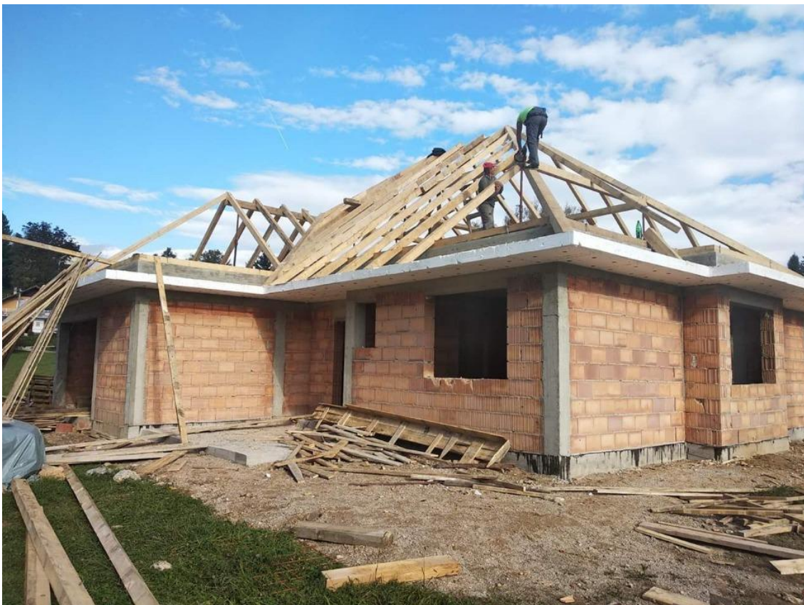
Slika 12 –Izrada krovišta. Izvor 33
