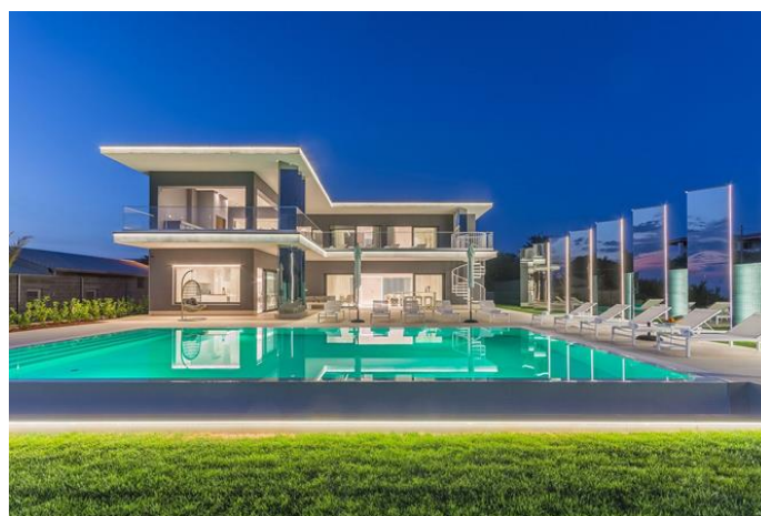
Slika 5 –Primjer moderne kuće za odmor. Izvor: 23
