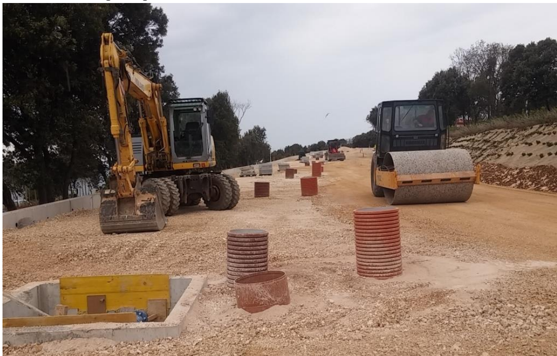
Slika 19: završna faza ugradnje (izvor: autor)
