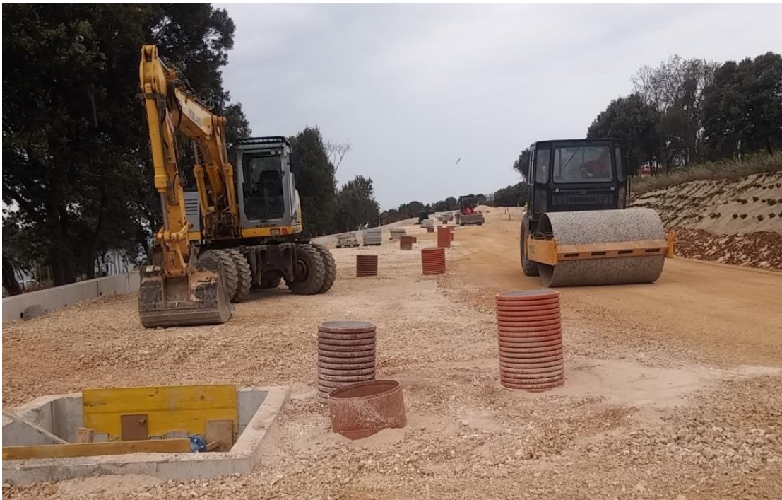
Slika 19: završna faza ugradnje (izvor: autor)
