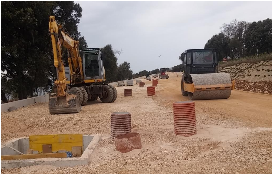
Slika 19: završna faza ugradnje (izvor: autor)
