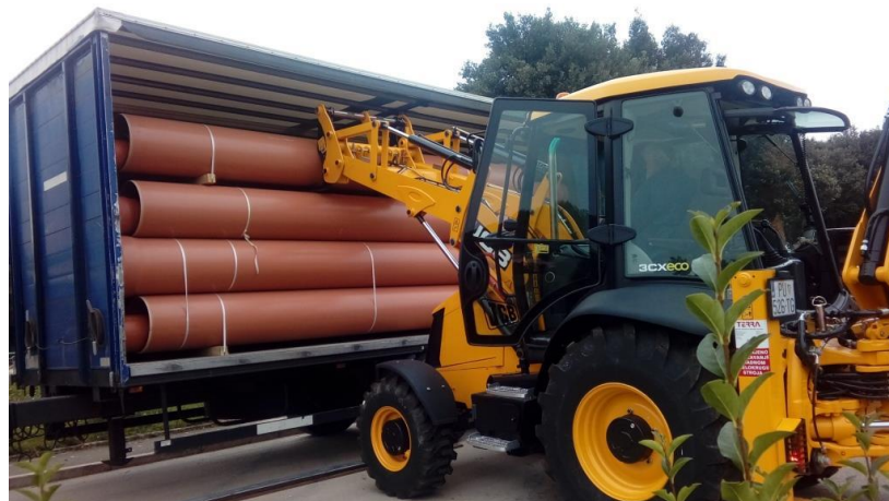
Slika 12: istovar cijevi (izvor: autor)
