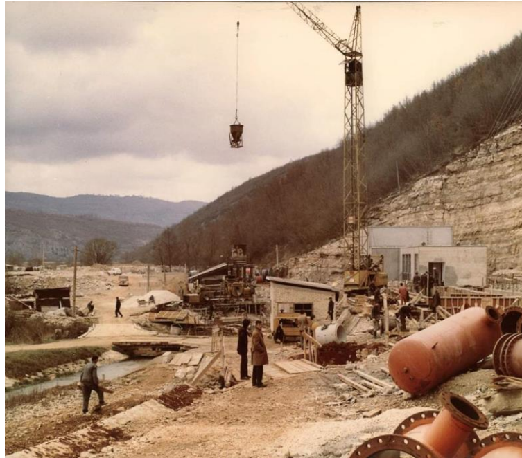
Slika 3: Izgradnja crpne stanice Gradole [15]
