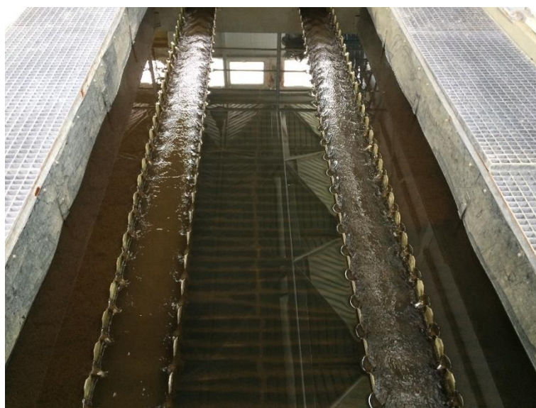
Slika 27: Pločasti taložnik sa vidljivim flokulama mulja [14]
