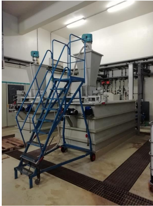
Slika 21: Uređaj za pripremu polielektrolita [Autor]
