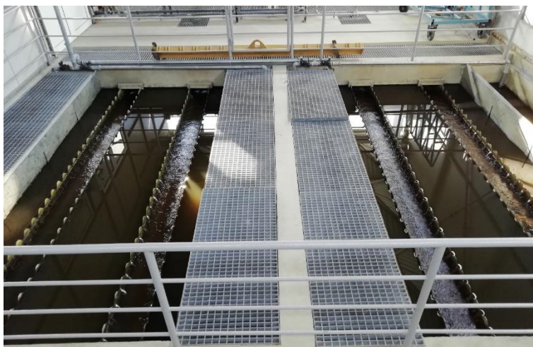
Slika 16: Obje linije pločastog taložnika u radu [Autor]
