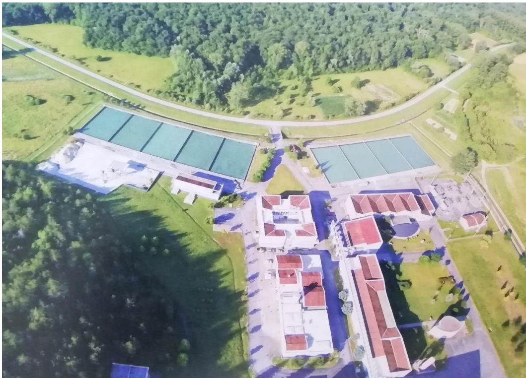
Slika 6: Postrojenje za kondicioniranje vode Butoniga [2]
