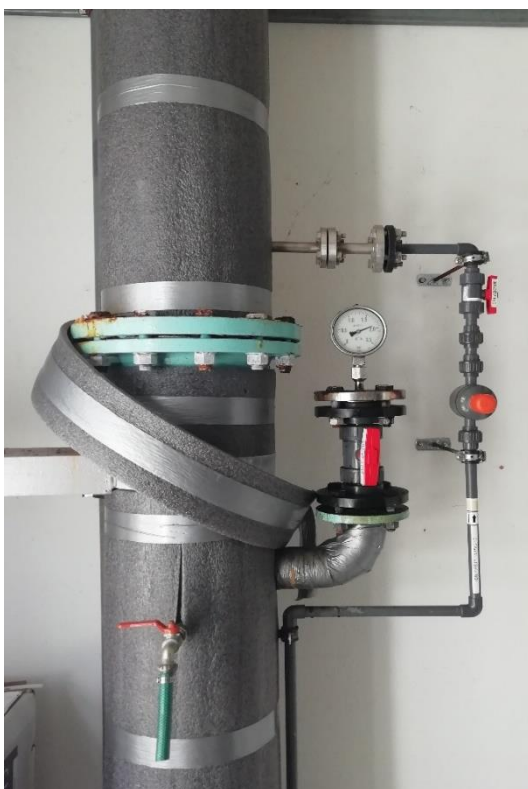
Slika 19: Pozicija doziranja anionskog polielektrolita [Autor]
