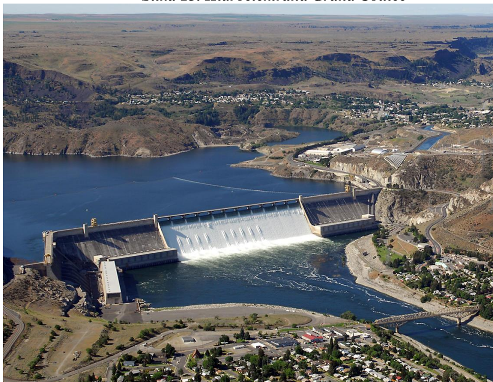
Slika 13. Hidroelektrana Grand Coulee
