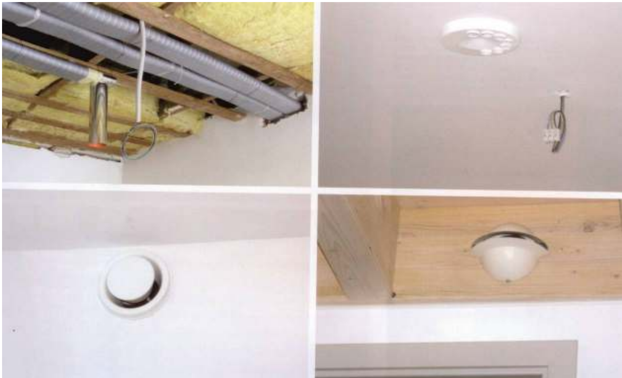
Slika 23. Kanali i mlaznice za ventilaciju
