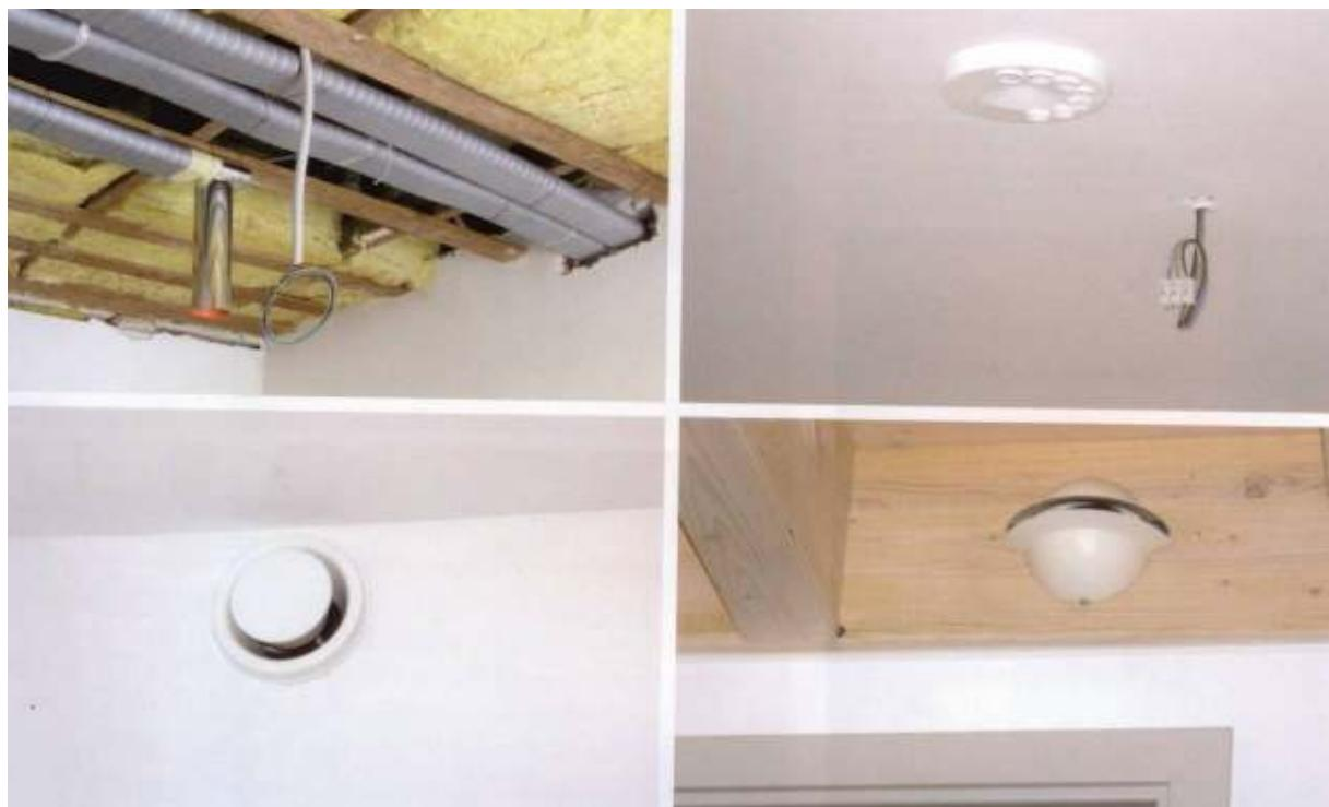
Slika 23. Kanali i mlaznice za ventilaciju
