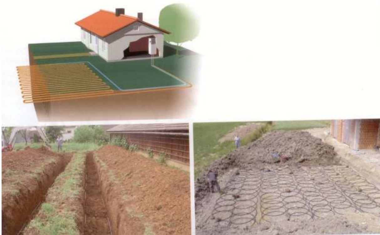
Slika 28. Različite izvedbe zemnih sakupljača - izmjenjivača topline
