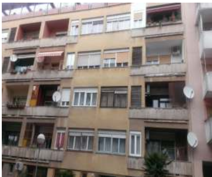
Slika 8.: Pročelja prije obnove
