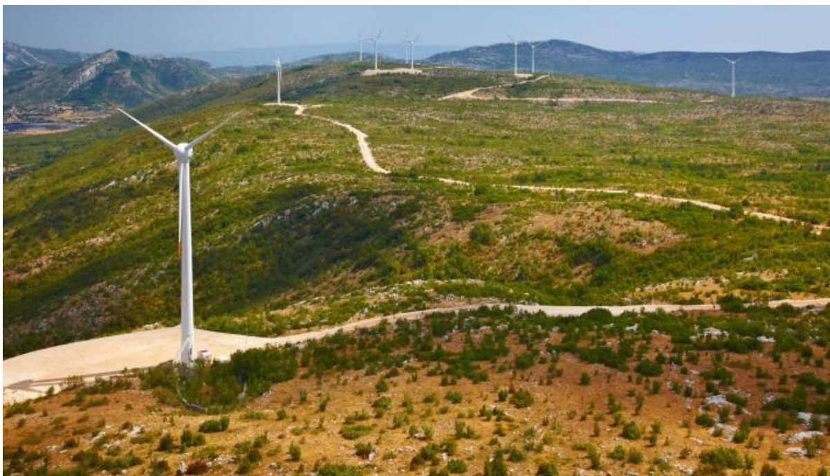
Slika 13: Vjetroelektrana Pometeno brdo
