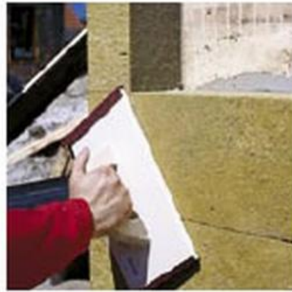
Kontaktni toplinsko izolacijski sustav
