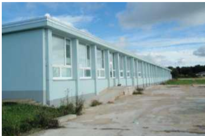
Slika 37. Dio zapadnog i južnog pročelja Industrijsko - obrtničke škole Pula poslije rekonstrukcije
