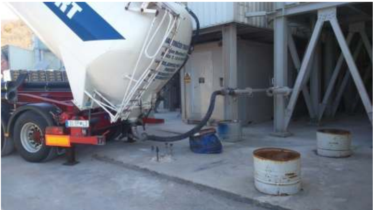
Slika 12.: Dopremanje veziva auto cisternom
