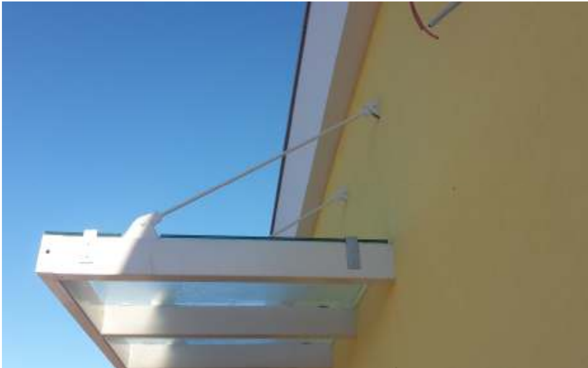
Slika 28: Bočna strana montirane nadstrešnice
