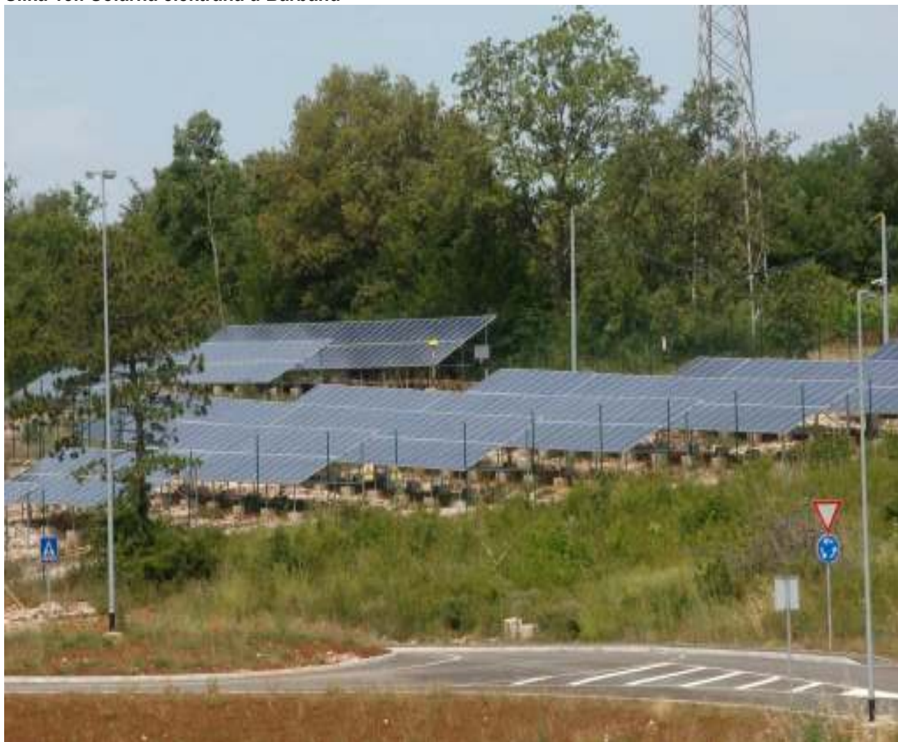
Slika 15.: Solarna elektrana u Barbanu
