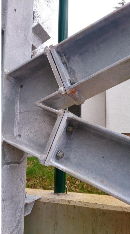
Slika 20. Detalj vijčanog spoja [7]
