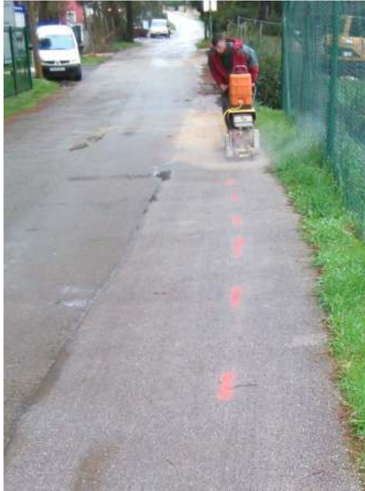
Slika 6.2.2.2. Primjer rezanja asfaltnog sloja motornom rezačicom [3]
