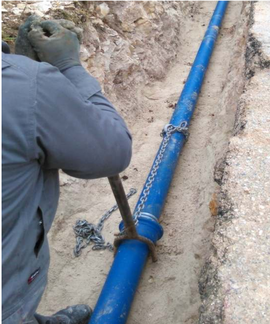
Slika 6.4.2. Naprava za spajanje cijevi sa naglavkom [3]
