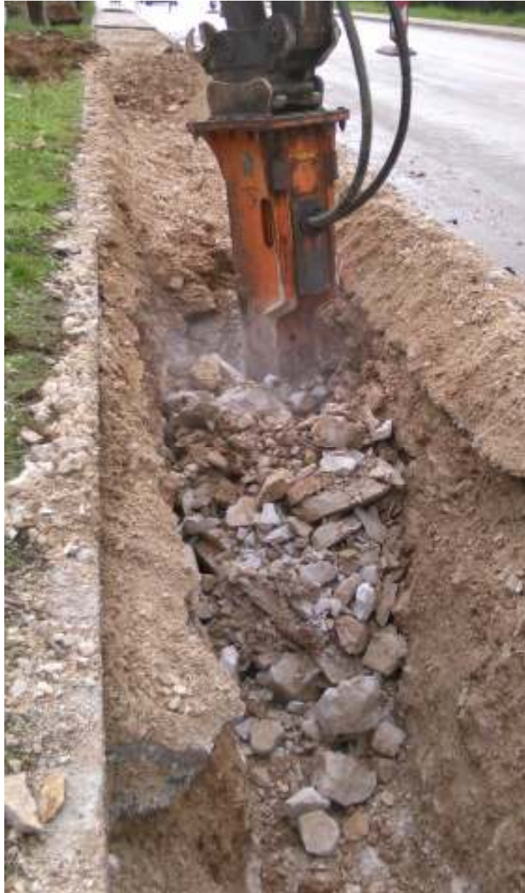
Slika 6.3.2. Primjer upotrebe hidrauličkog strojnog čekića [3]
