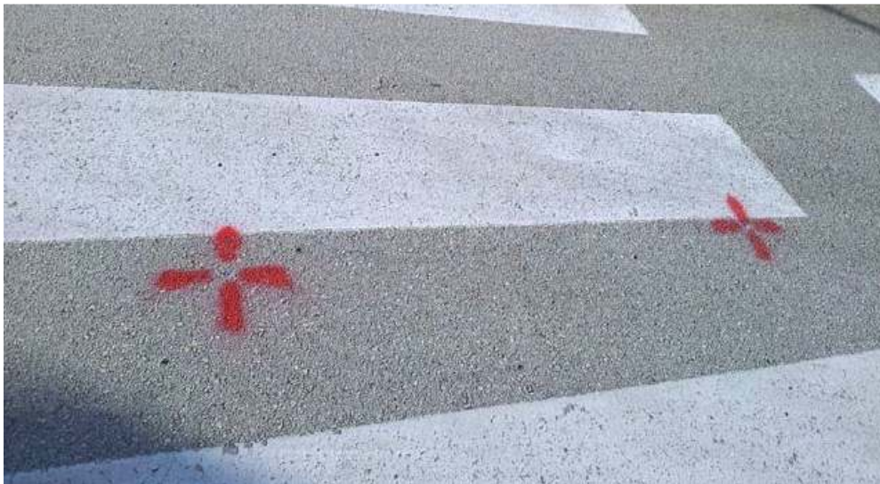
Slika 6.2.1. Iskolčene točke stabilizirane bolcnom na asfaltu [2]
