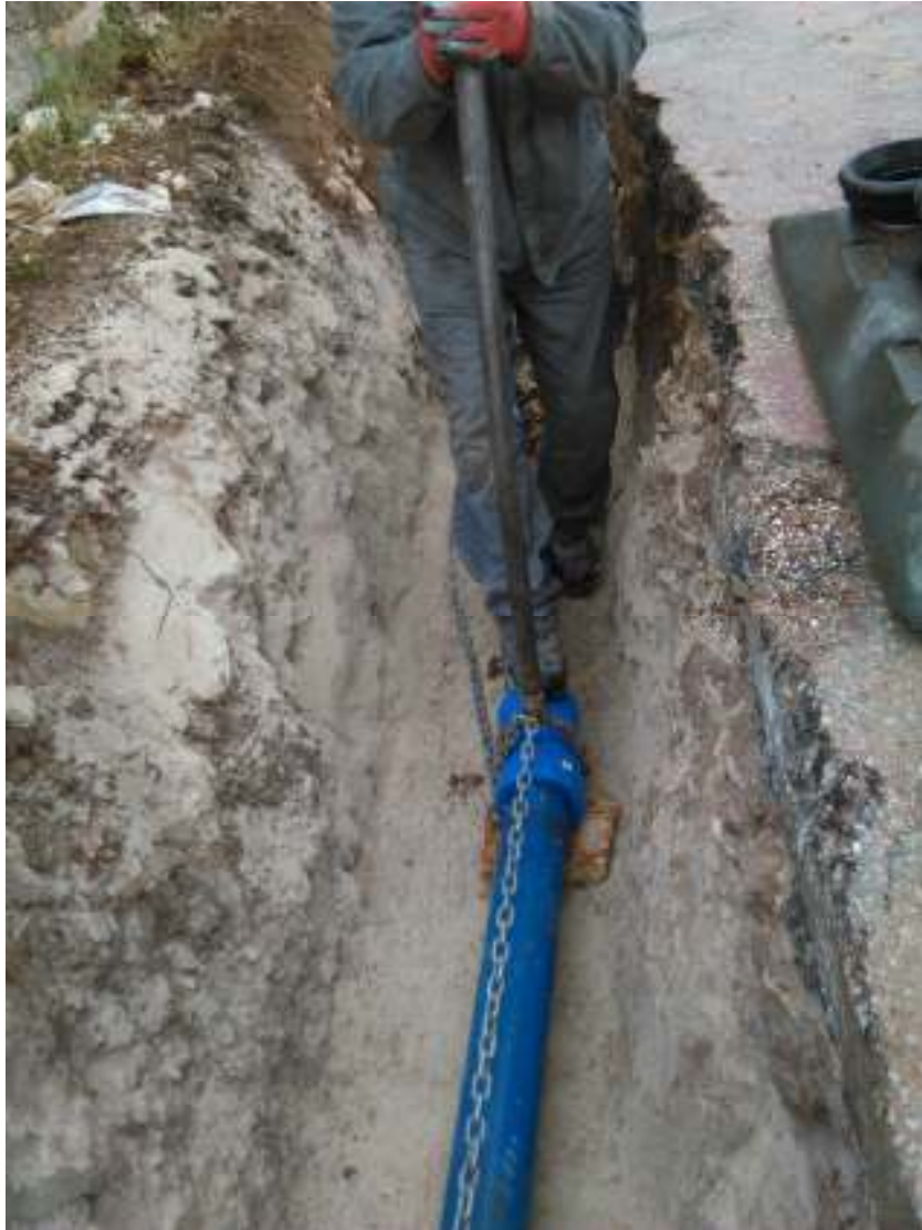
Slika 6.4.3. Spajanje fazona napravom kućne izrade [3]
