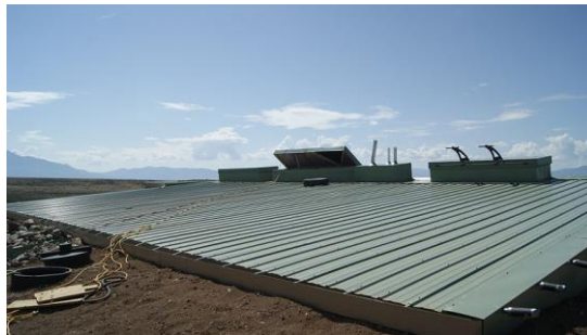
Slika 41. Postavljeni završni limeni pokrov na krov Earthshipa
