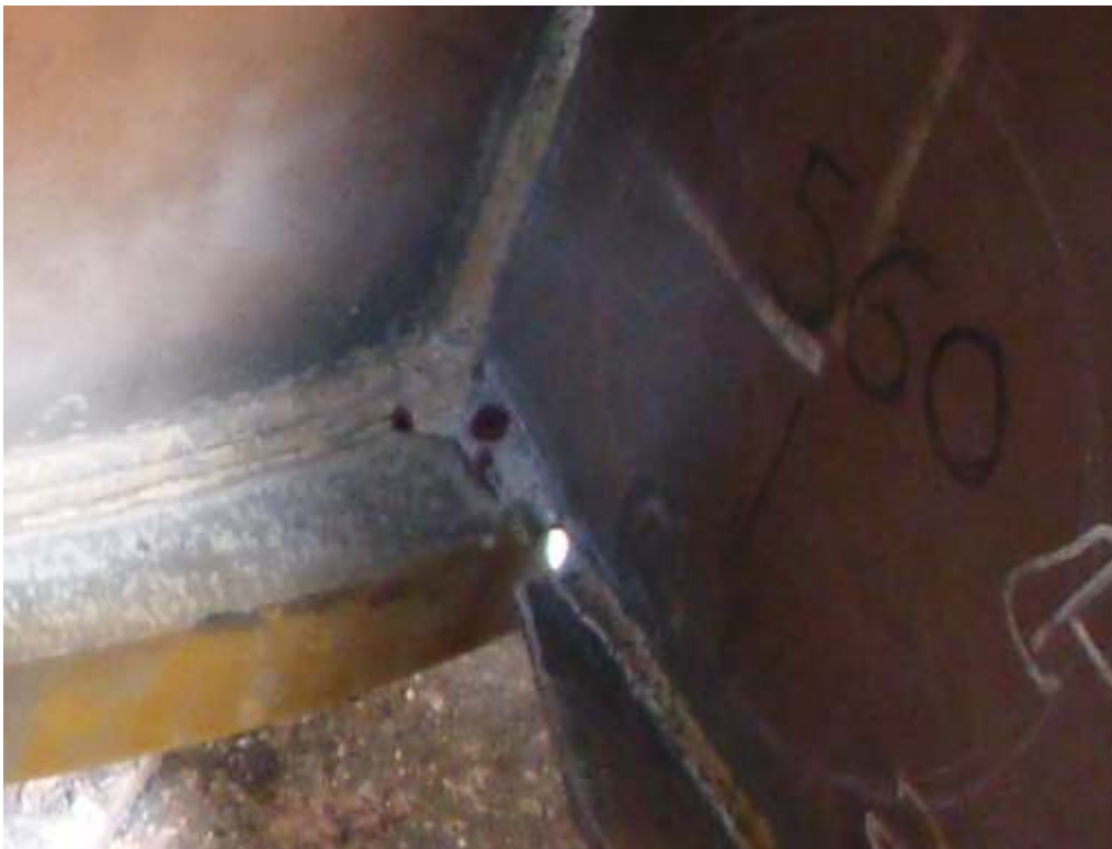
Slika 18. Prikaz probiranja penetranta kroz zavar.
