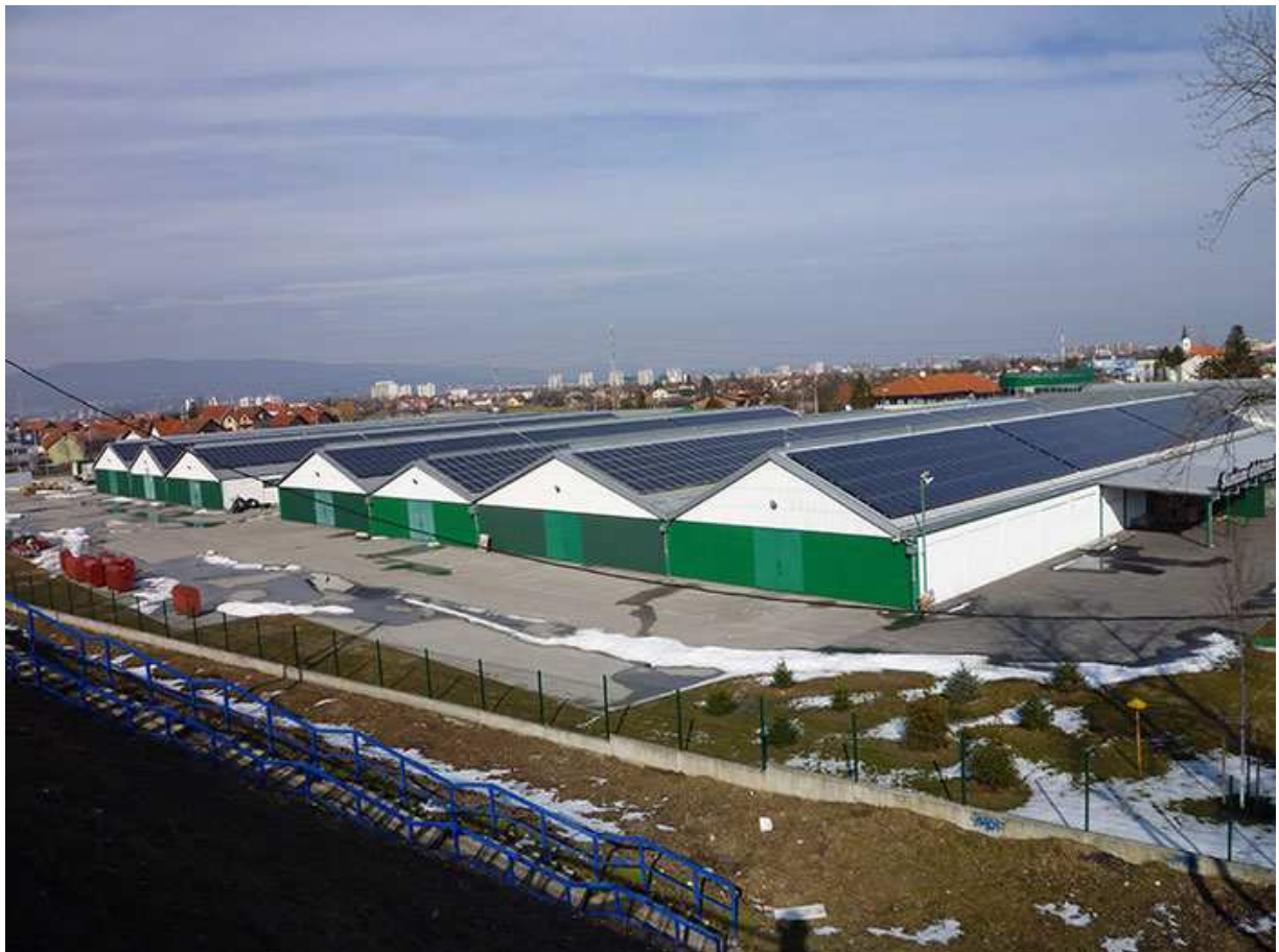
Slika 7.2.3 Solarna elektrana Petrokov; Izvor: www.geo-solar.hr
