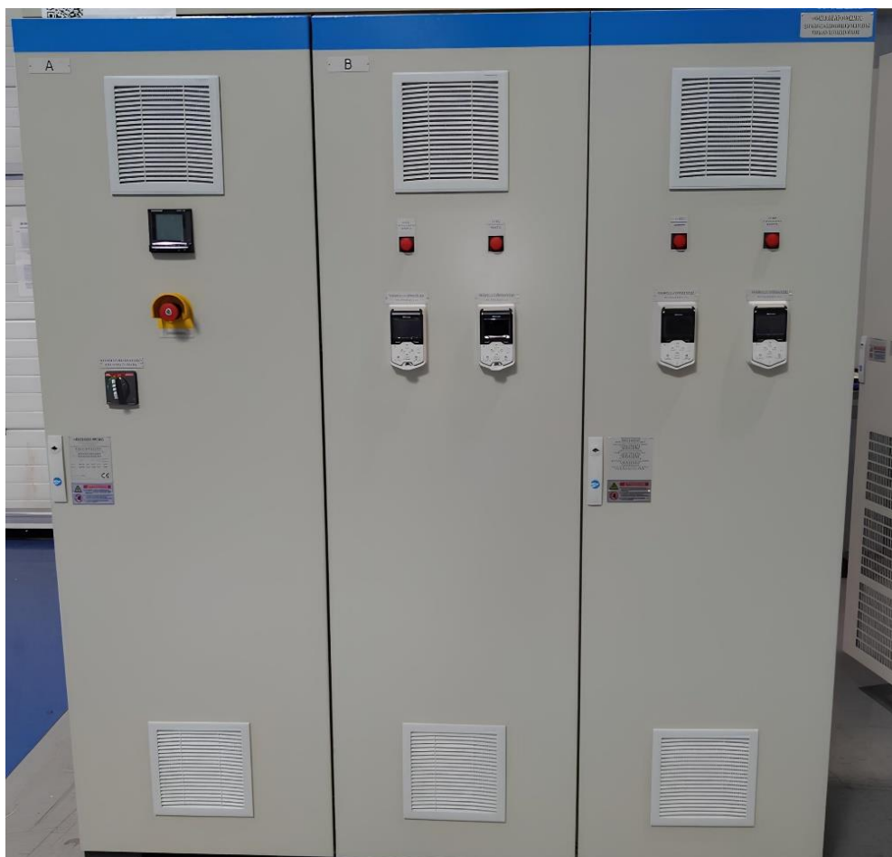
Slika 2. Ventilacija elektroormara.
