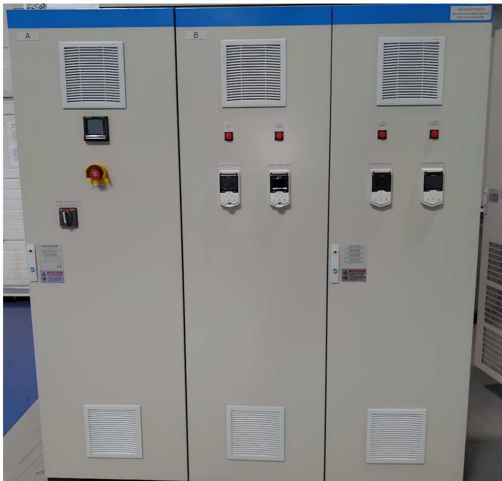
Slika 2. Ventilacija elektroormara.
