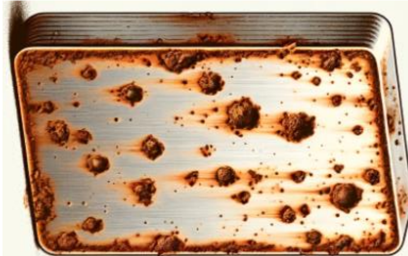
Slika 3. Komad metala s jednoličnom korozijom
