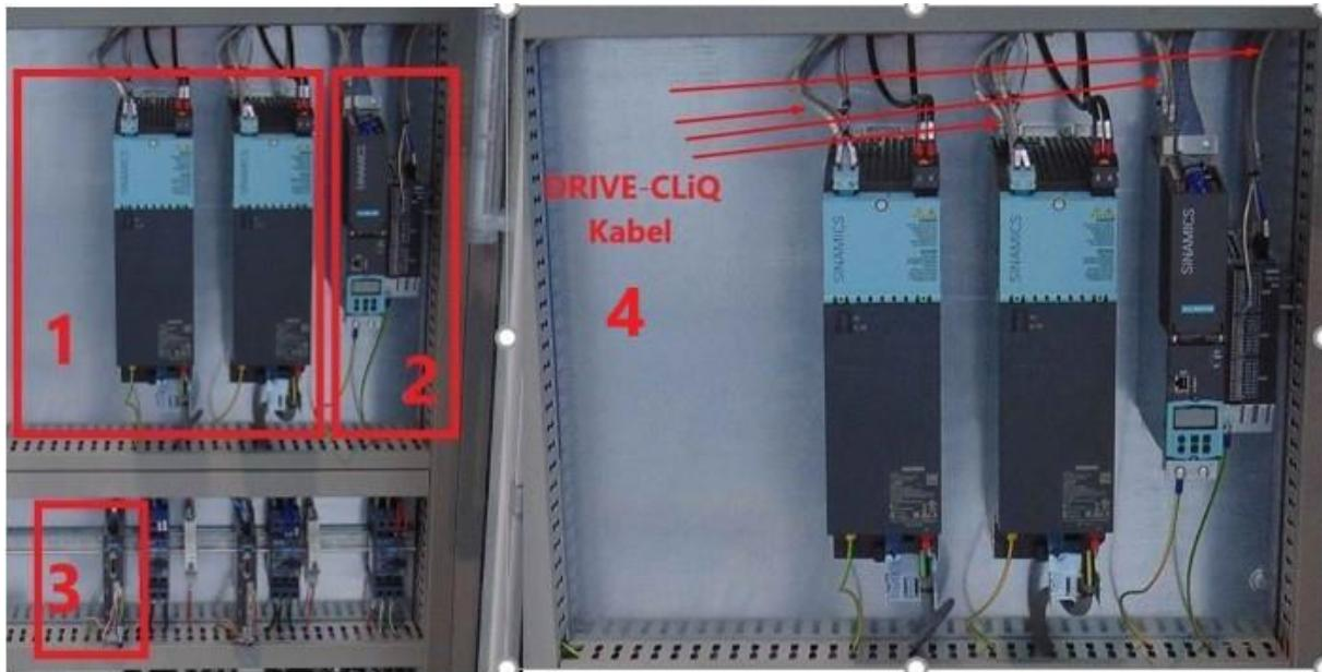
**Slika 16.** Praktičan primjer Siemens Sinamics S120 modularni sustava i CU320-2
