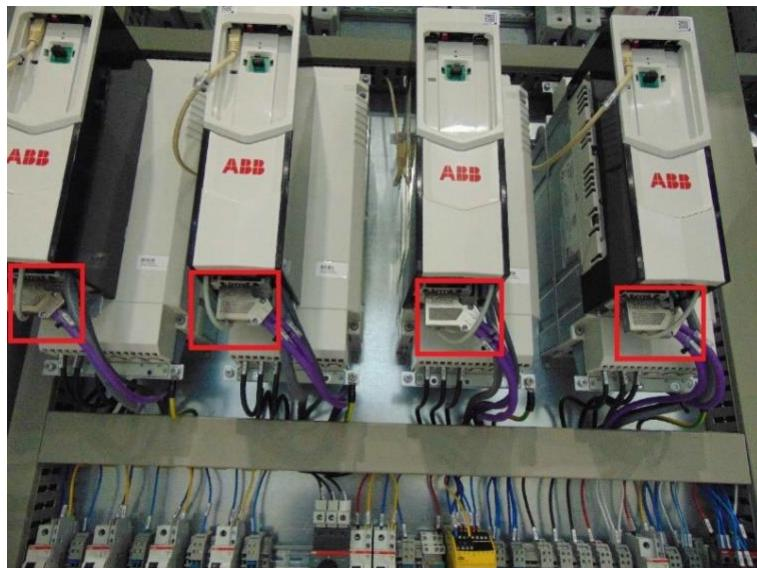
**Slika 15.** Spajanje VFD-a u PROFIBUS mrežu šivanjem
