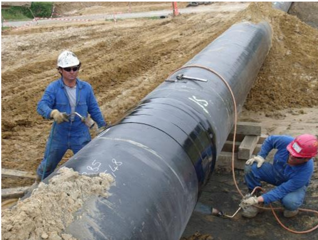
Slika 16. Primjer bitumenizacije cjevovoda
