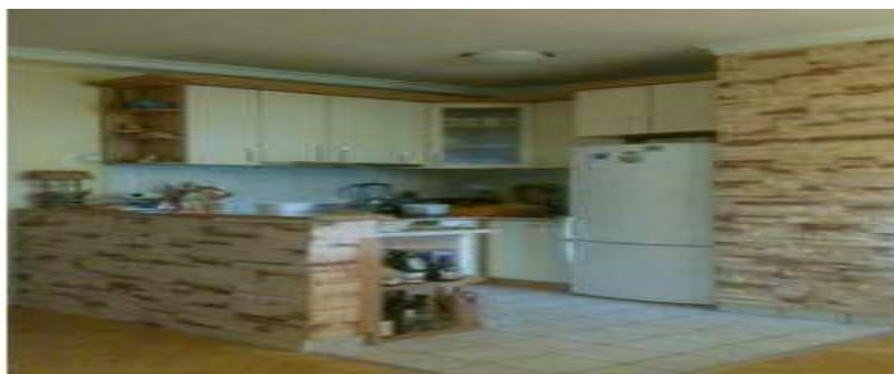
Slika 42. Zid obložen tučenim kamenom
