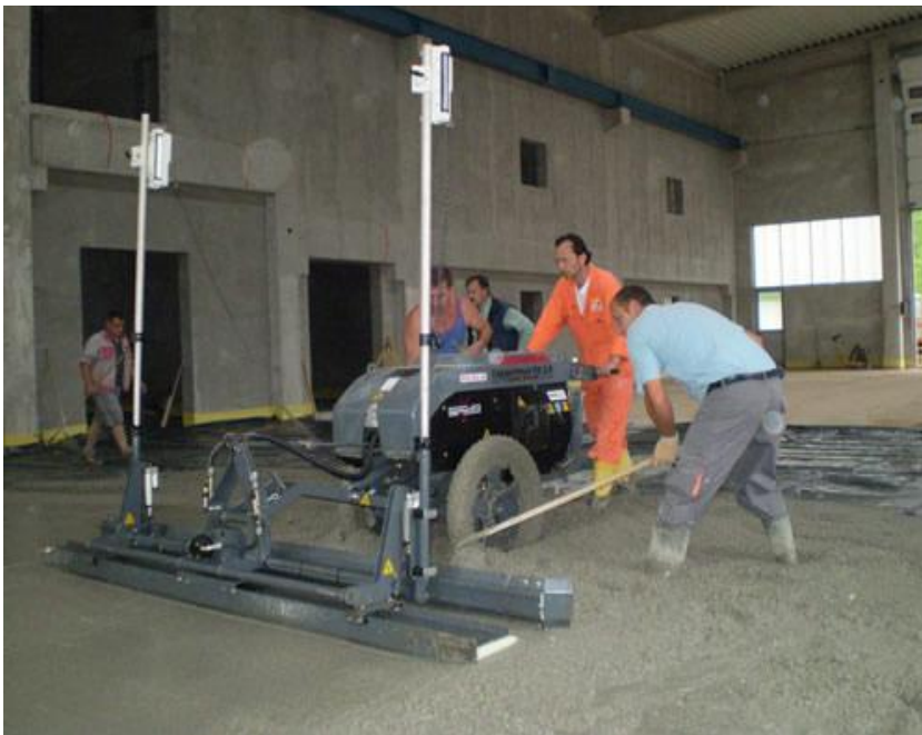
Slika 32. Poravnavanje laserskom vibro letvom
