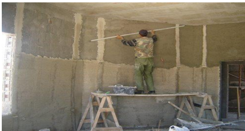
Slika 35. Žbukanje klasičnim cementnovapnenim mortom
