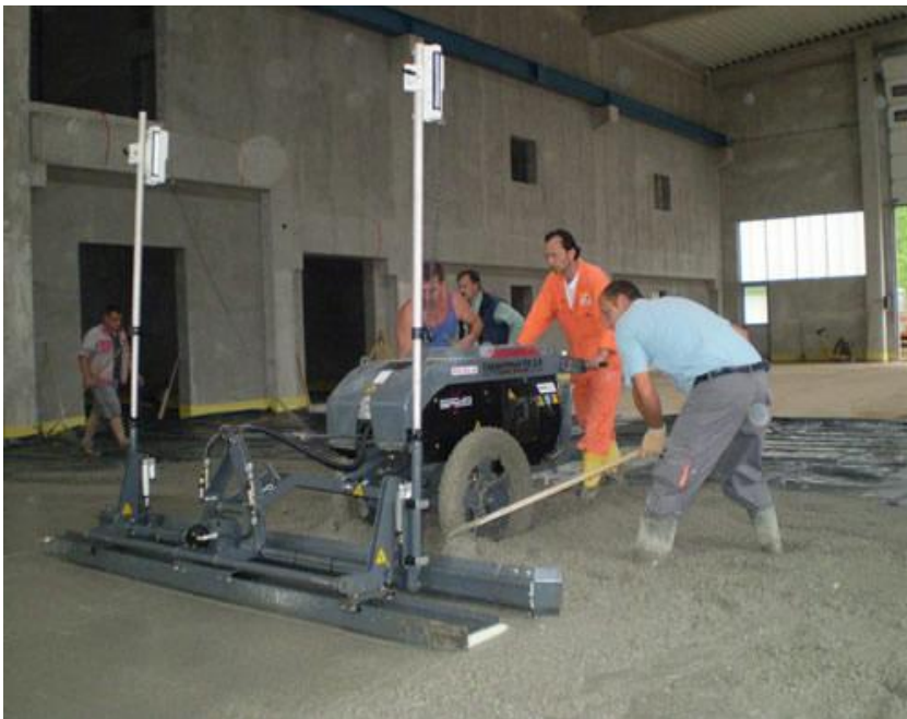
Slika 32. Poravnavanje laserskom vibro letvom
