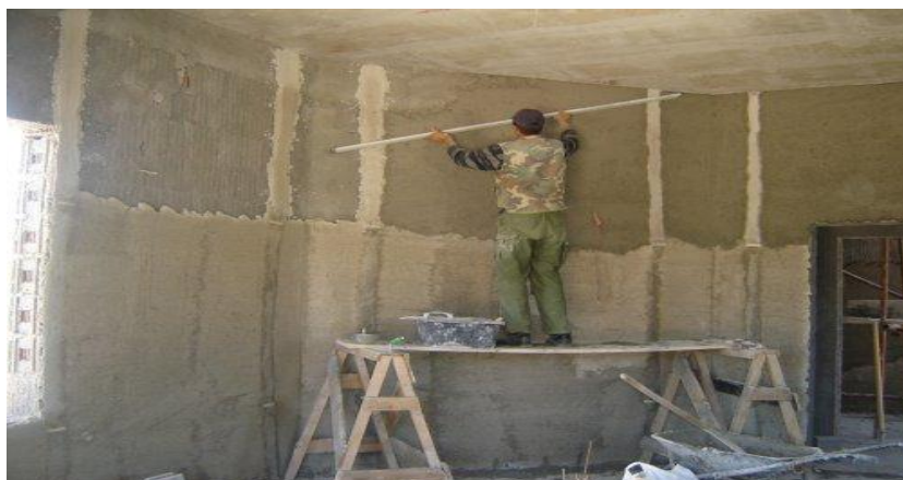
Slika 35. Žbukanje klasičnim cementnovapnenim mortom
