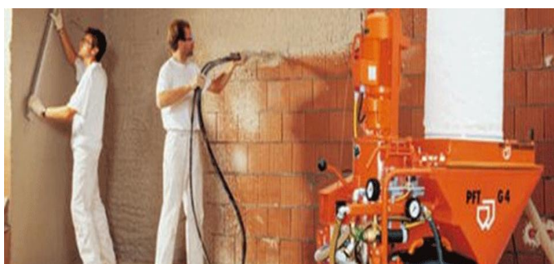
Slika 36. Strojno žbukanje gotovim mortom
