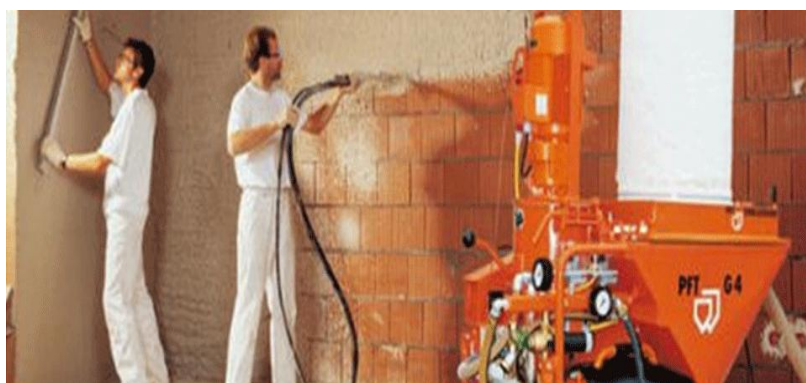
Slika 36. Strojno žbukanje gotovim mortom
