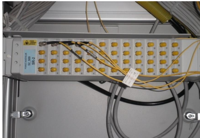
Slika 17: Ugradni 19" razdjelnik KGS FODU UR 48
