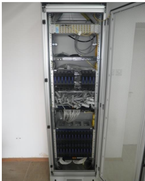
Slika 16: Komunikacijski ormar
