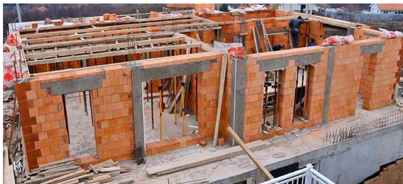
Slika 10 – Izgradnja prve etaže. Izvor 31
