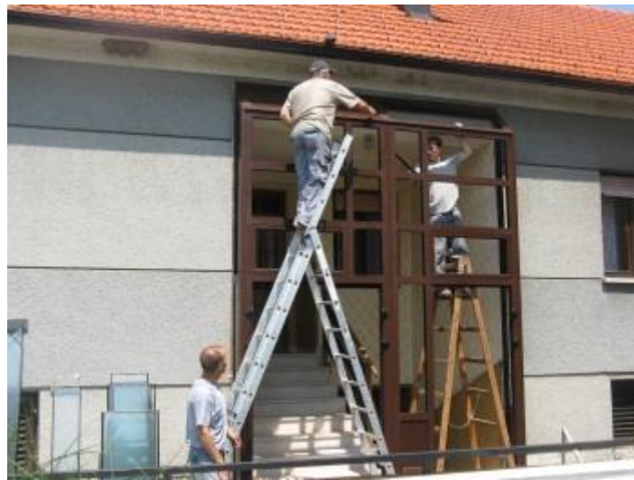
Slika 13 – Montaža stolarije. Izvor 34
