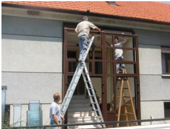
Slika 13 – Montaža stolarije. Izvor 34
