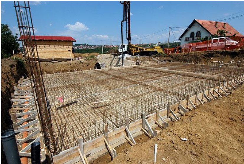
Slika 9 –Primjer izgradnje temelja. Izvor 30
