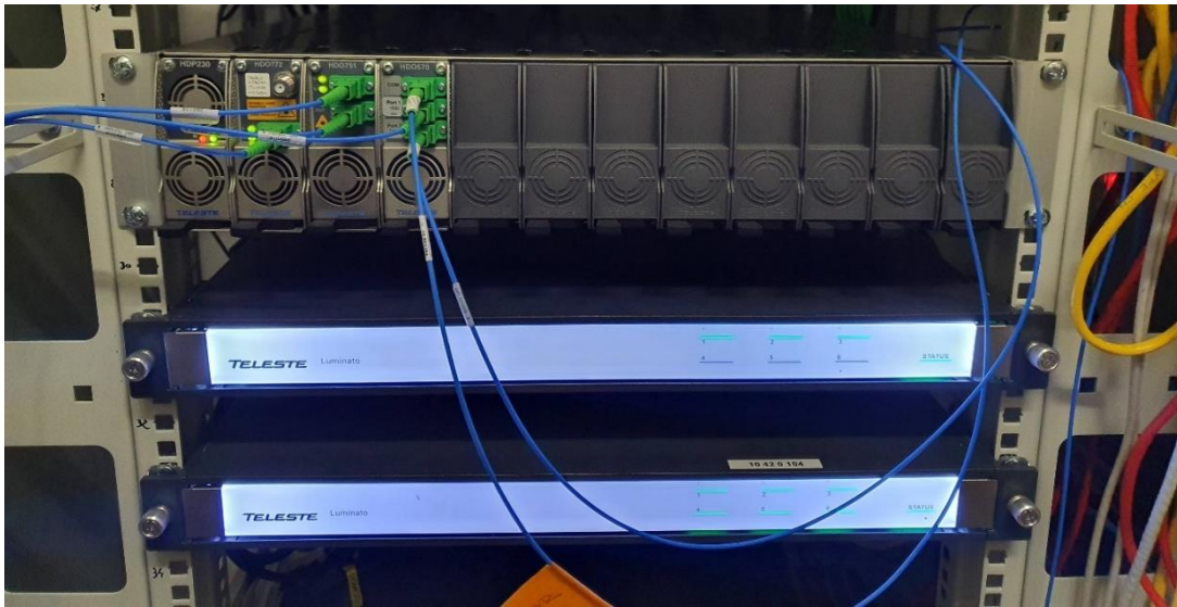
Slika 18: „WDM uređaj, tkzv.combiner“
