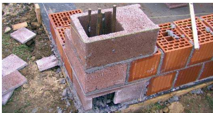
Slika 17. gradnja ciglom, izvor www.wienerberger.hr
