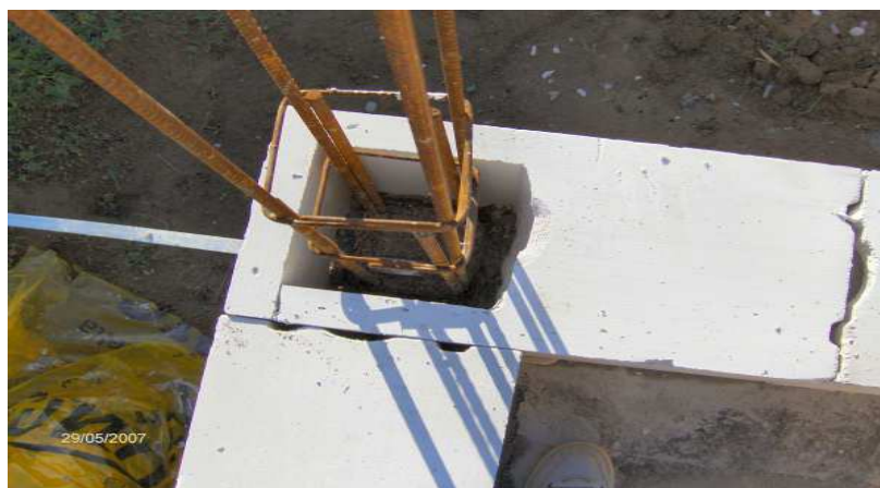
Slika 18. gradnja porobetonom, izvor www.ytong.hr
