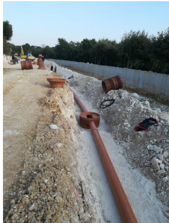
Slika 16: ugradnja cijevi (izvor: autor)
