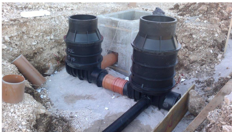
Slika: 22. Primjer ugradnje okna drugog tipa materijala (Izvor: autor)
