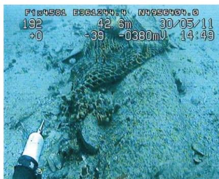
*Slika 34. Prikaz oštećenja plinskih podvodnih cijevi [48]*
