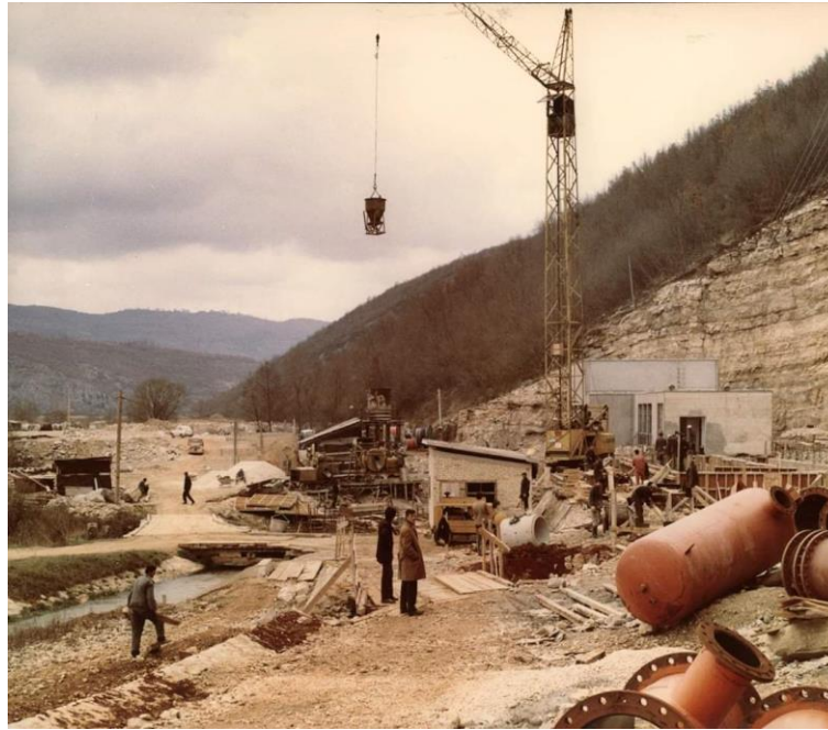
Slika 3: Izgradnja crpne stanice Gradole [15]
