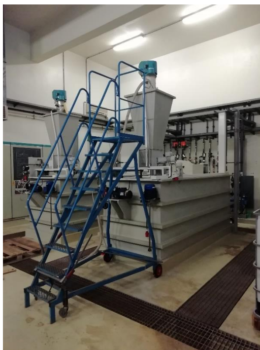
Slika 21: Uređaj za pripremu polielektrolita [Autor]
