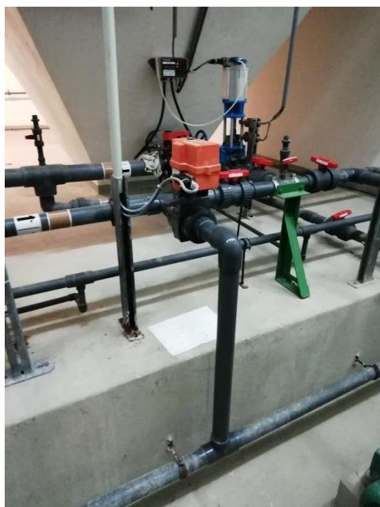
Slika 31: Elektromagnetni ventil na dnu pločastog taložnika [Autor]
