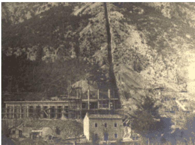
Slika 2: Izgradnja crpne stanice Sv. Stjepan [15]
