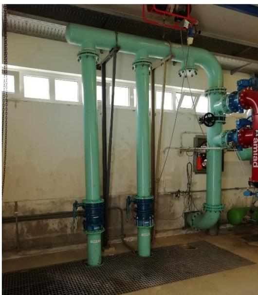
Slika 17: Cijevi za dovod vode od pranja filtera na taložnik [Autor]
