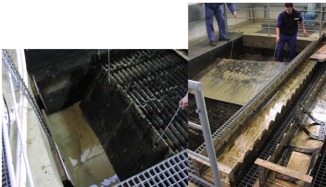
Slika 23: Vađenje ploča taložnika koje je potrebno oprati [15]
