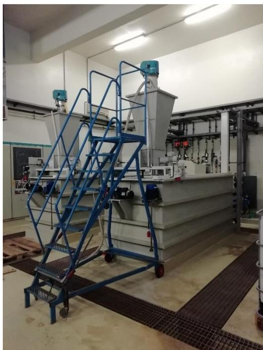
Slika 21: Uređaj za pripremu polielektrolita [Autor]
