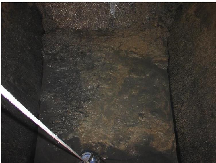
Slika 25: Ispumpavanje zaostalog staloženog mulja potopnom pumpom [15]
