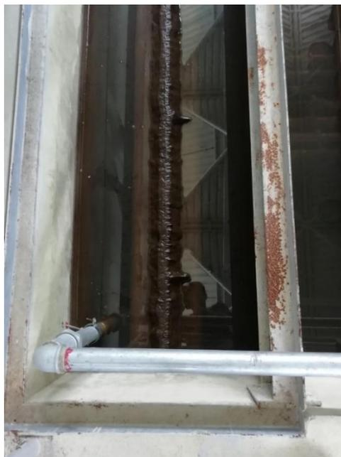
Slika 29: Vertikalna vodovodna cijev na obodu taložnika [Autor]
