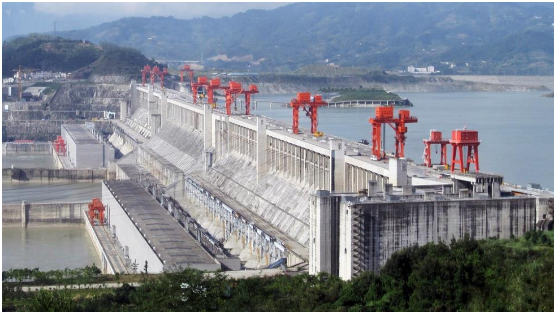
Slika 14. Hidroelektrana Tri klanca
