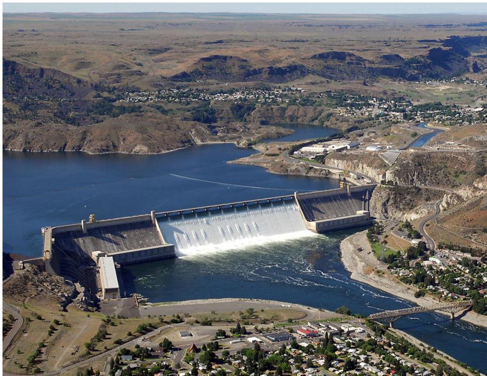
Slika 13. Hidroelektrana Grand Coulee
