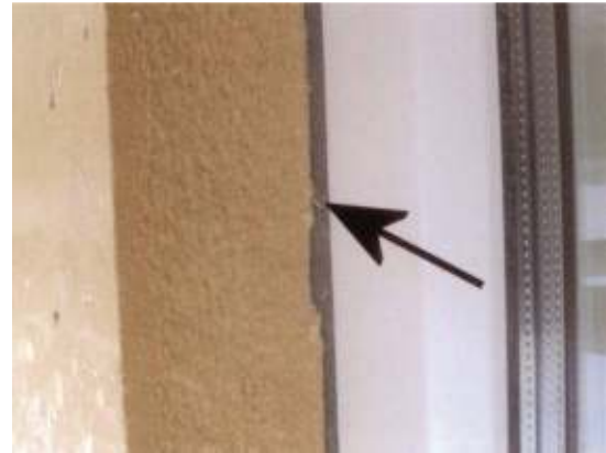
Slika 18. Ekspanzivna traka omogućava zrakonepropusno prilijeganje prozora na neravnim površinama
