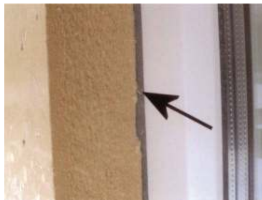
Slika 18. Ekspanzivna traka omogućava zrakonepropusno prilijeganje prozora na neravnim površinama
