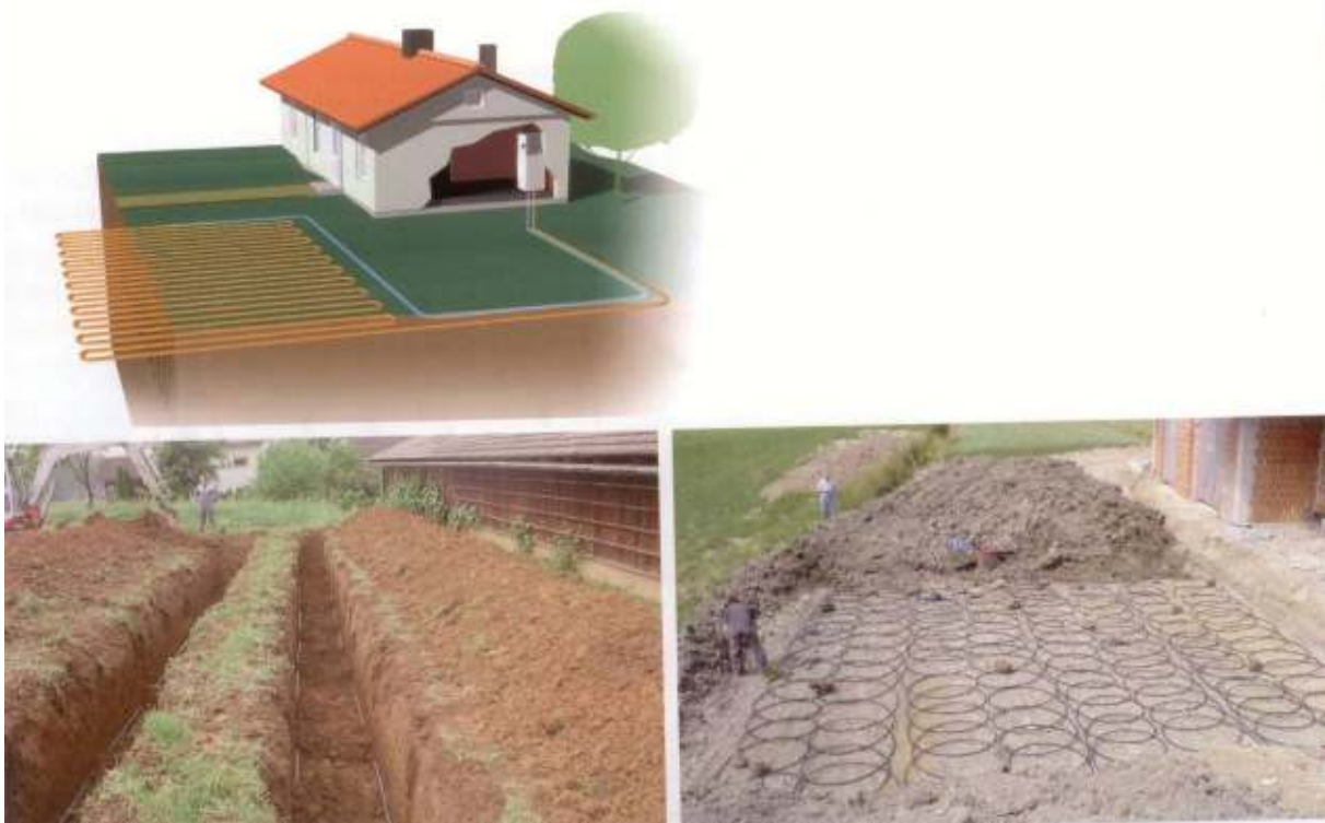
Slika 28. Različite izvedbe zemnih sakupljača - izmjenjivača topline
