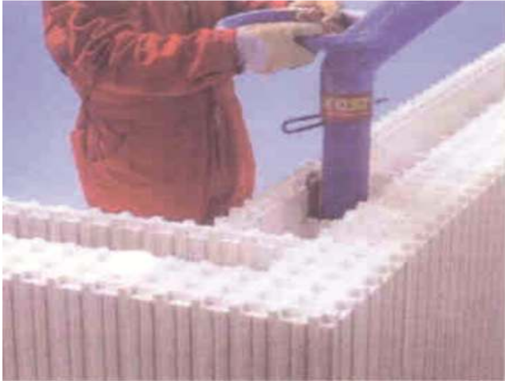
Slika 5. Gradnja s oplatnim elementima od polistirena
