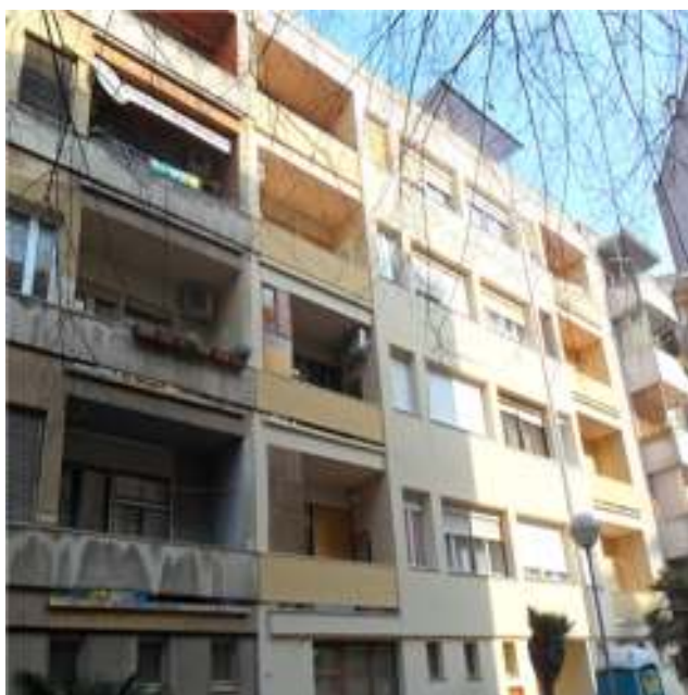
Slika 9.: Pročelja nakon obnove
