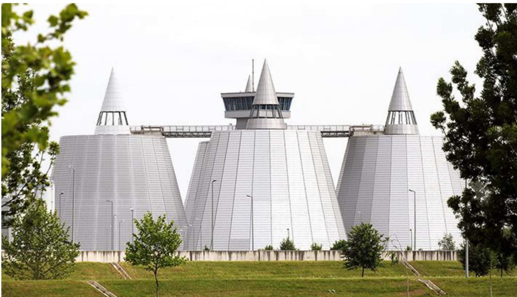
Slika 6. Tornjevi anaerobne obrade mulja na uređaju za pročišćavanje u Zagrebu
